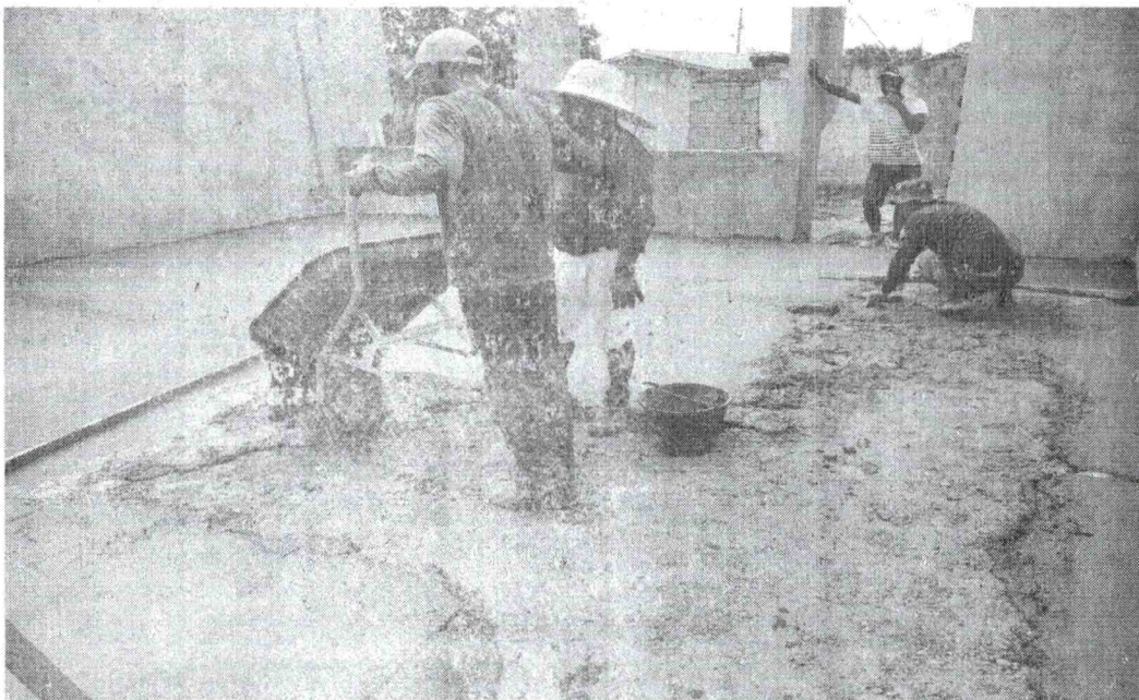
FOTO 04 – LASTRO DE CONCRETO E=7CM
