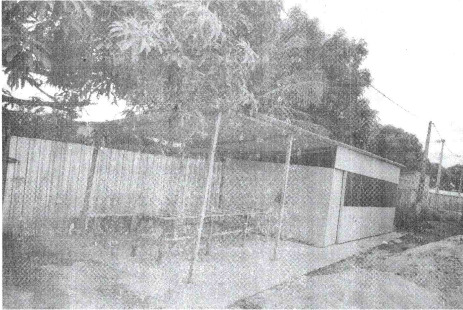
FOTO 02 - BARRACÃO DA OBRA
