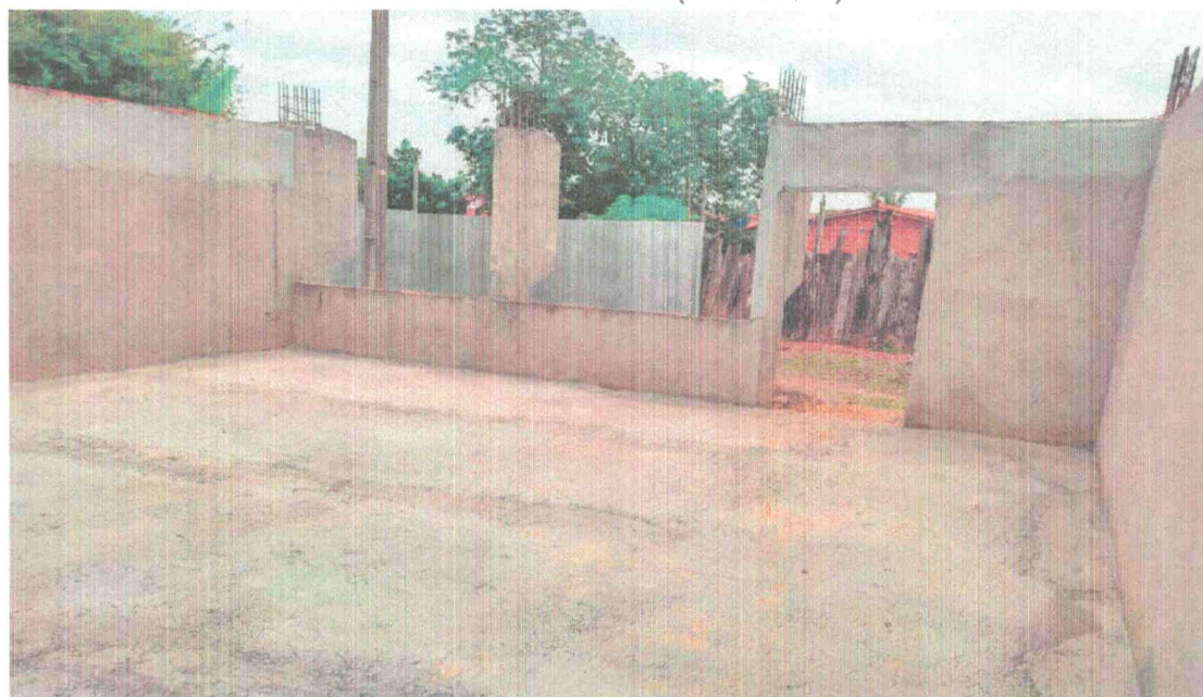
FOTO 04 – LASTRO DE CONCRETO E=7CM(executado)
