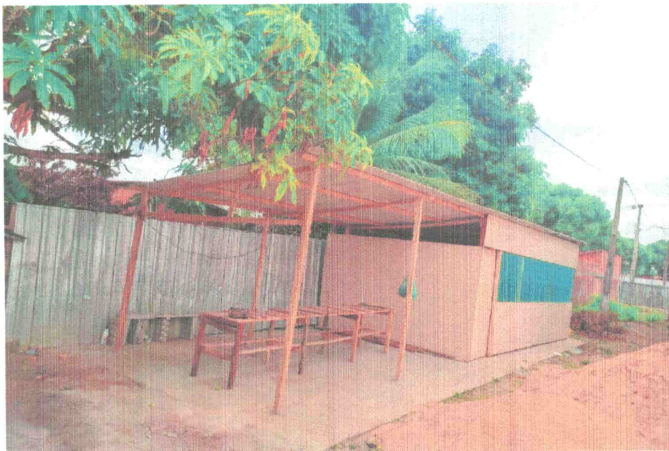
FOTO 02 - BARRACÃO DA OBRA
