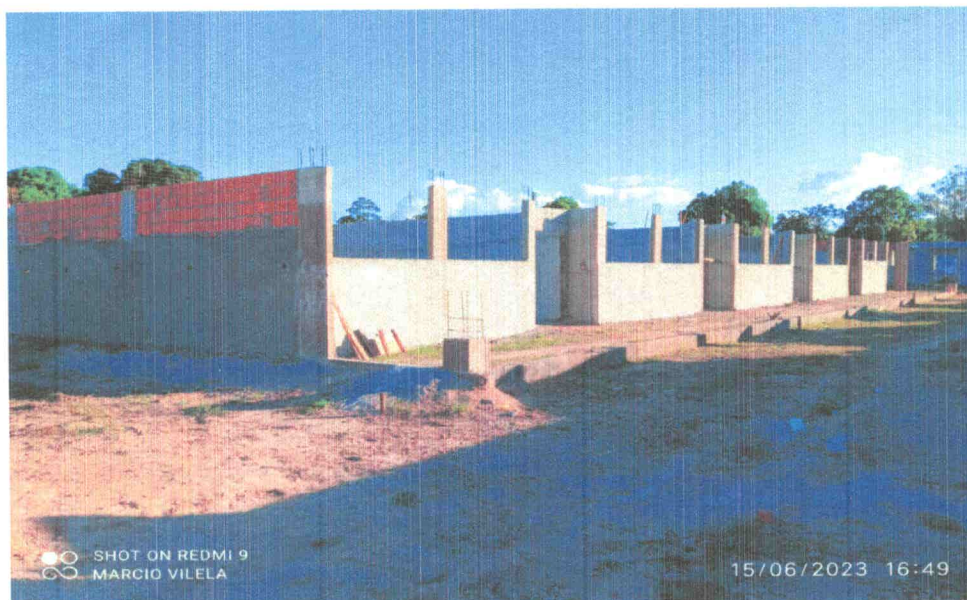
FOTO 03 - REBOCO E LEVANTE BLOCO C
