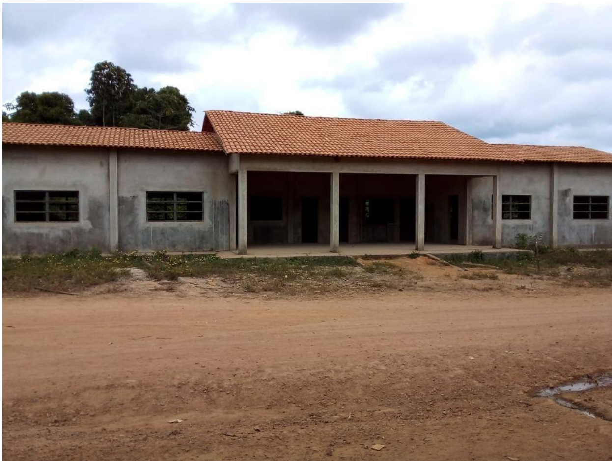
Figura 18: Vista da cobertura. Fonte: Elaboração própria.
