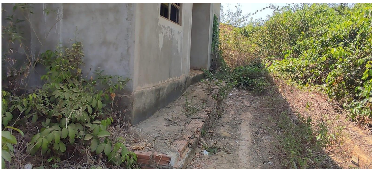
Figura 14: Vista lateral esquerda bloco sala de aula parte dos fundos. Fonte: Elaboração própria.
