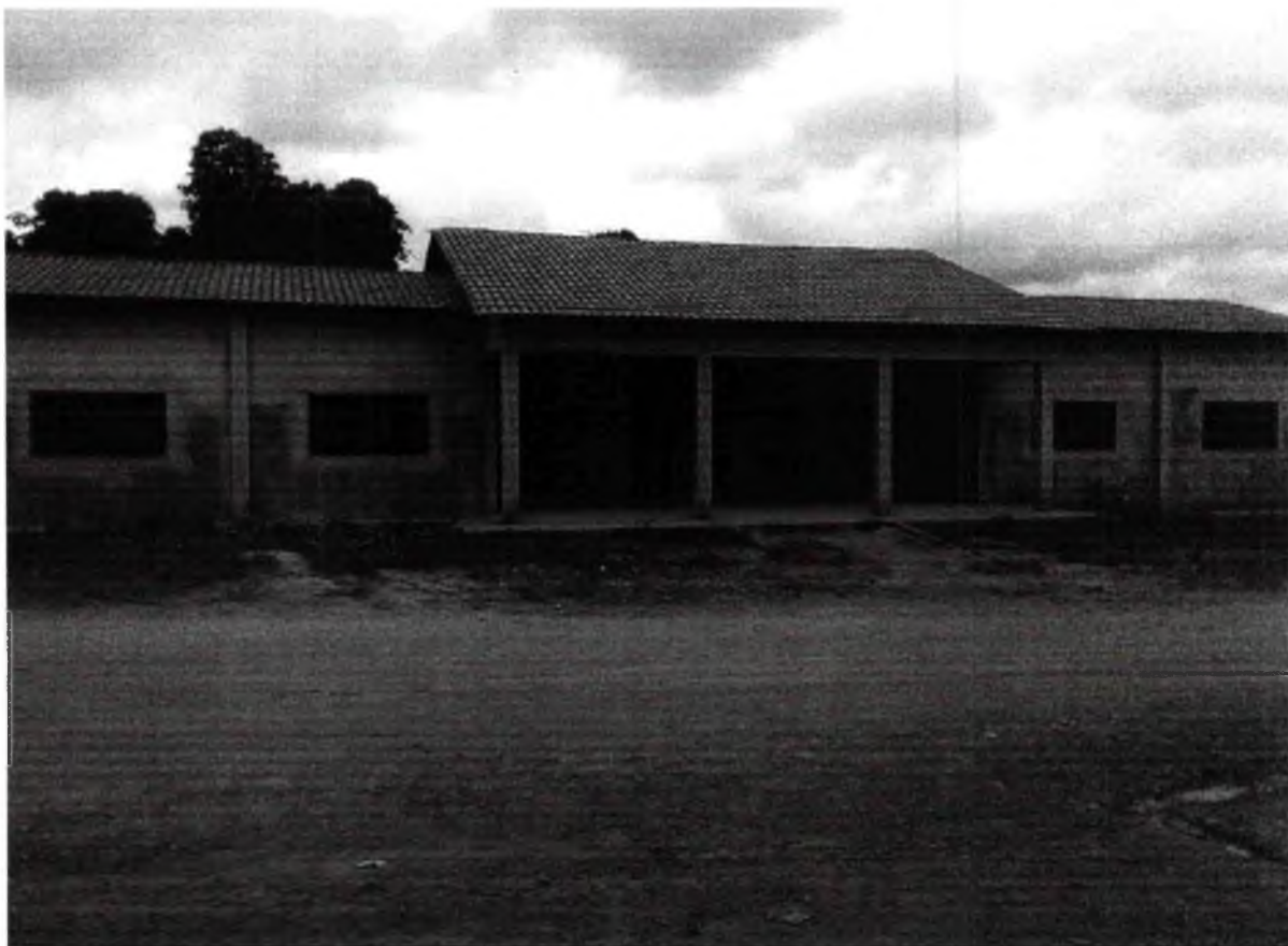
Figura 18: Vista da cobertura. Fonte: Elaboração própria.
