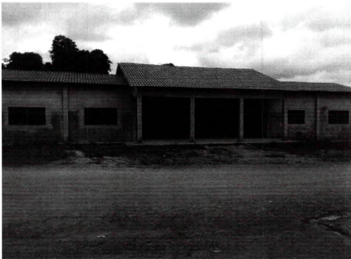
Figura 18: Vista da cobertura. Fonte: Elaboração própria.
